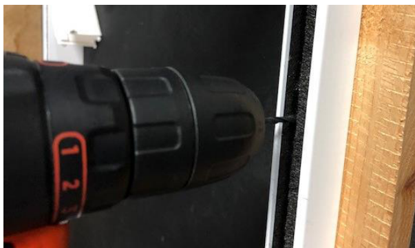
Perçage de la coulisse
