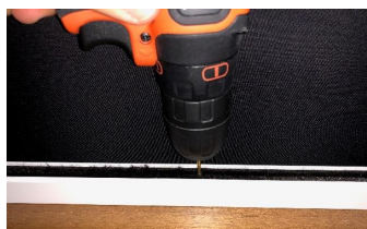
Perçage des coulisses
