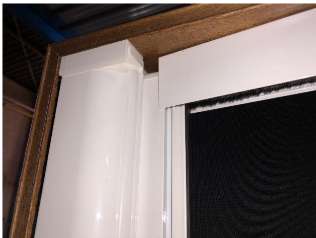
Mise en place côté coffre
