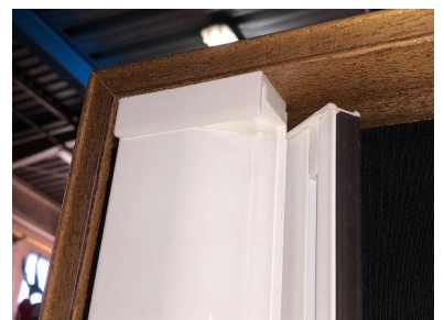
Coffre en place
