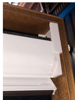
Coffre en place
